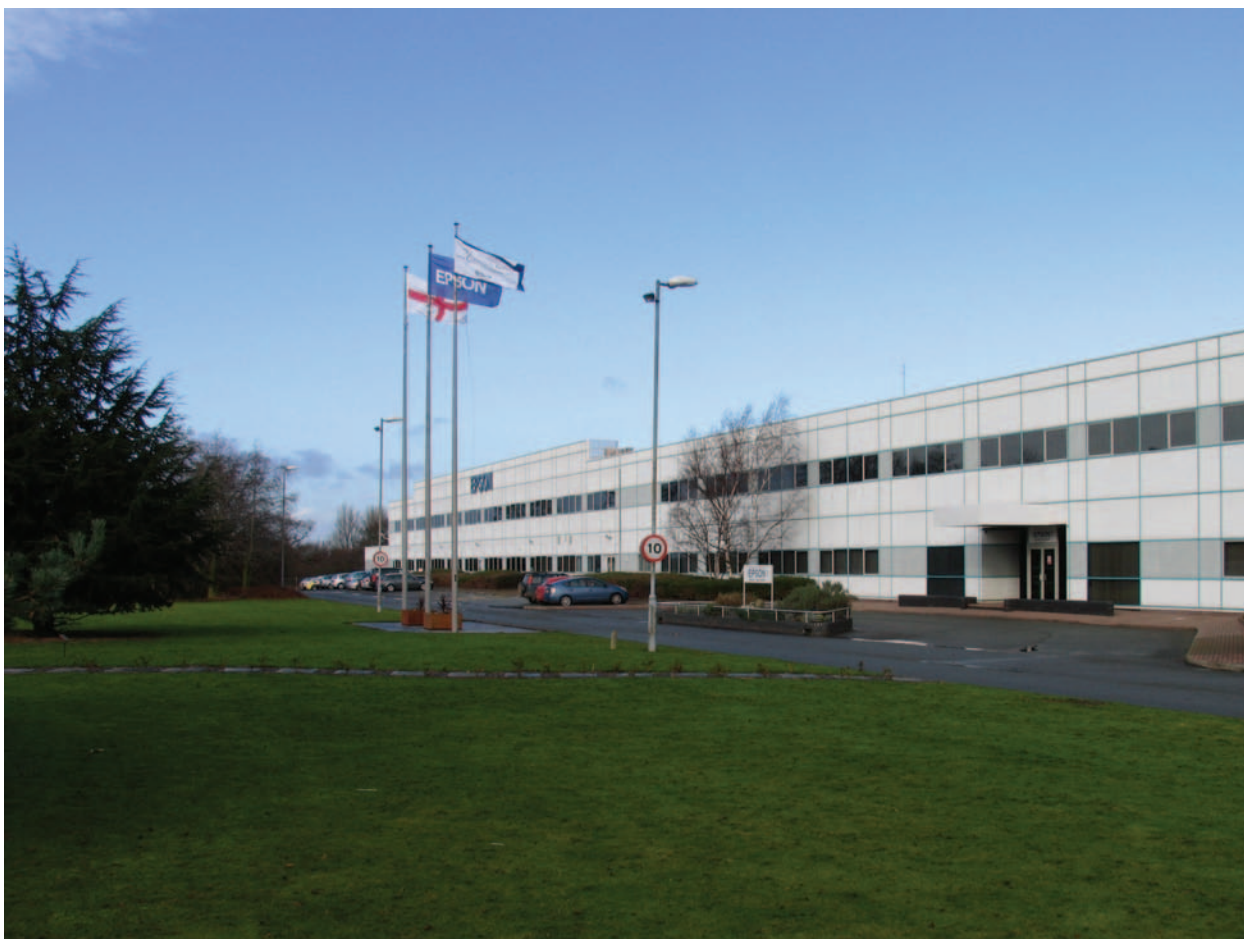
Рис. 17. Завод Epson Telford.
